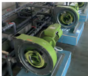
Dosificación de cal ALP30N
